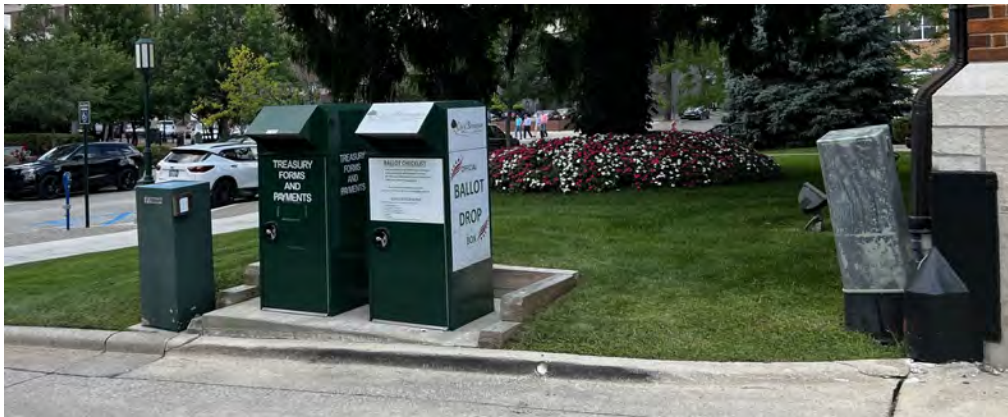
IMAGES 3.1.05 ICE HAZARD
